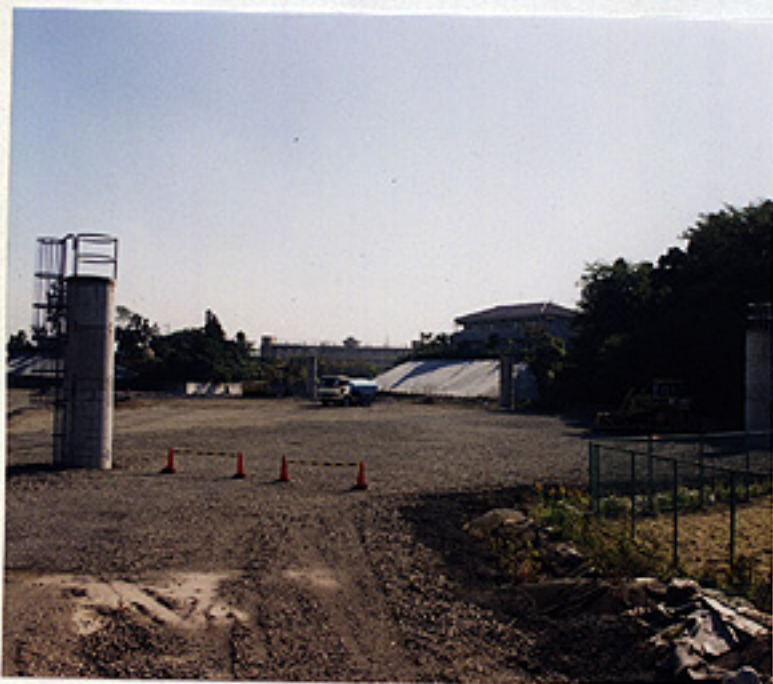
富勢にあるゴミの最終処分場、埋め立て、公害の問題が生じるため、残さの少ない焼却炉が求められている
