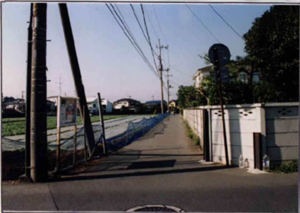
車一台がやっとの2.7mしかなかった八つ原地区入口(写真上)。今では5m道路に拡幅され永年の地域の願いが実現し、消防車や救急車も入れるようになりました(写真右)。次はその先の方です。
