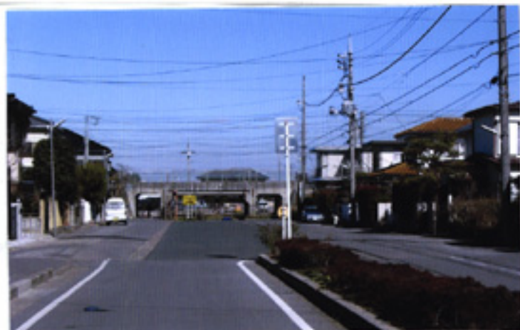
写真は豊上町の東武線との交差部分。吉野沢高野台線の延伸の進捗状況は予定の17年開通が大幅に遅れ19年完成予定に変更した所である。目下、旭東防衛側の用地交渉が進み、問題は東武線との交差部分の工事費用が莫大になるということです。国道6号線側は、今年度中に用地買収が進み、来期には3年計画で工事着手のこと。
